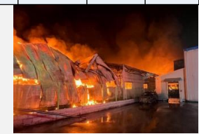
Kimpo Warehouse Fire (2024.02.19)
